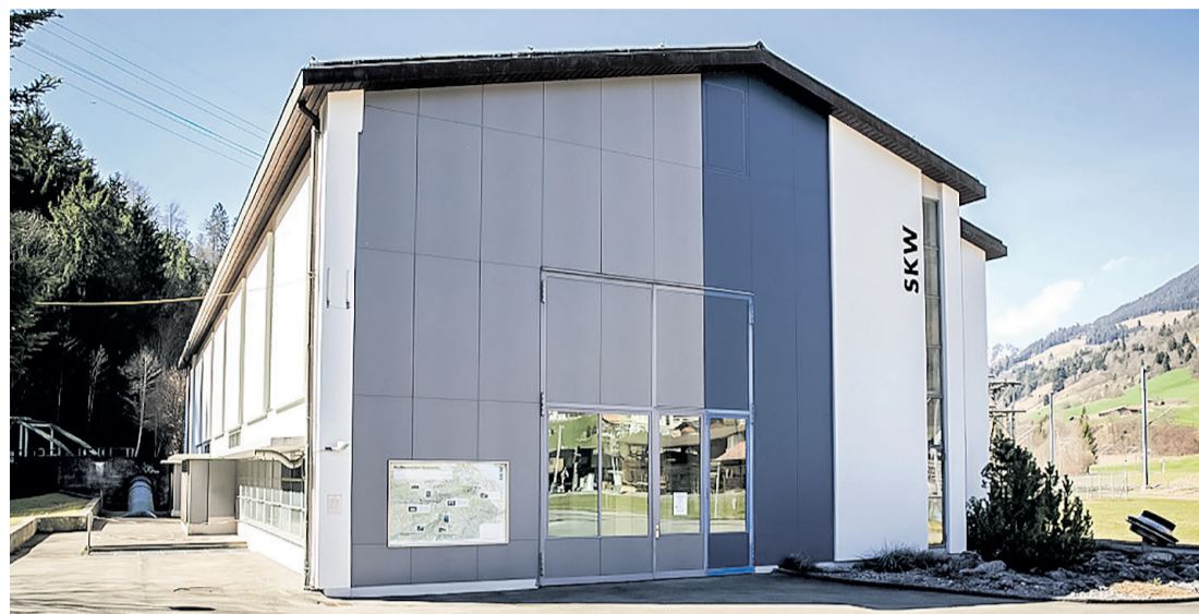
In Erlenbach haben die BKW das Wasserkraftwerk stillgelegt. Grund ist ein eingestürzter Stollen.
